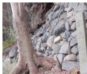
石垣跡 (自然石の野面積みで裏込め石あり)
