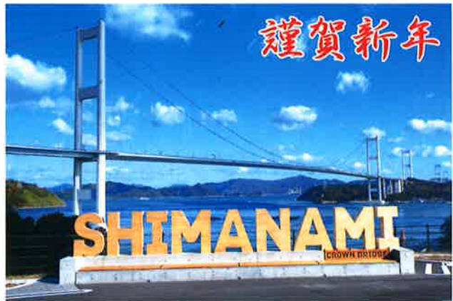
クラウン・ブリッジ（来島海峡大橋）
