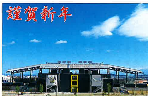
建設中の里山スタジアム
