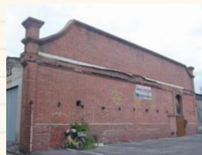
① 株興業舎第一工場跡 (通町)
